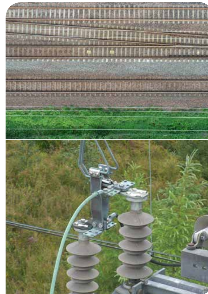
En drönare kan göra allt från att räkna bultar och titta på snedställda slipers till att inspektera kontaktledning, mäta avstånd och bedöma vegetationen kring spårområdet.
