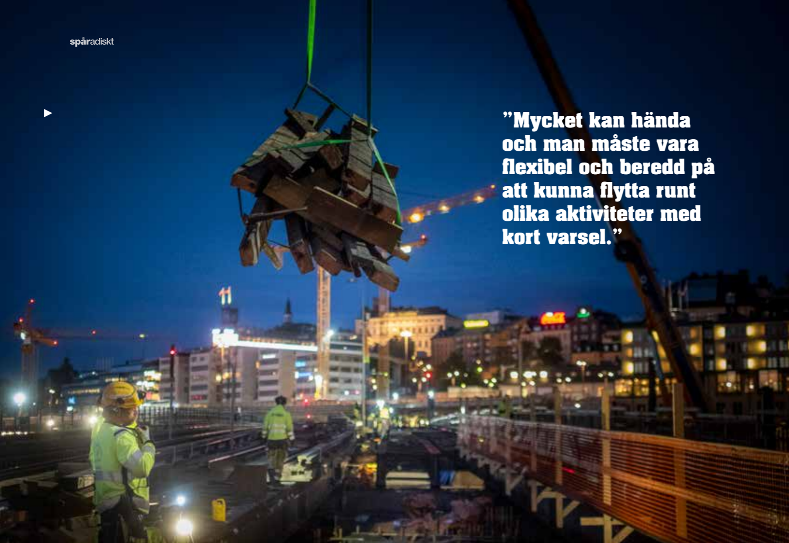
Brodelarna i höghållfast rostfritt stål lyfts på plats en och en med hjälp av en mobilkran som är placerad på en präm i Mälaren.
