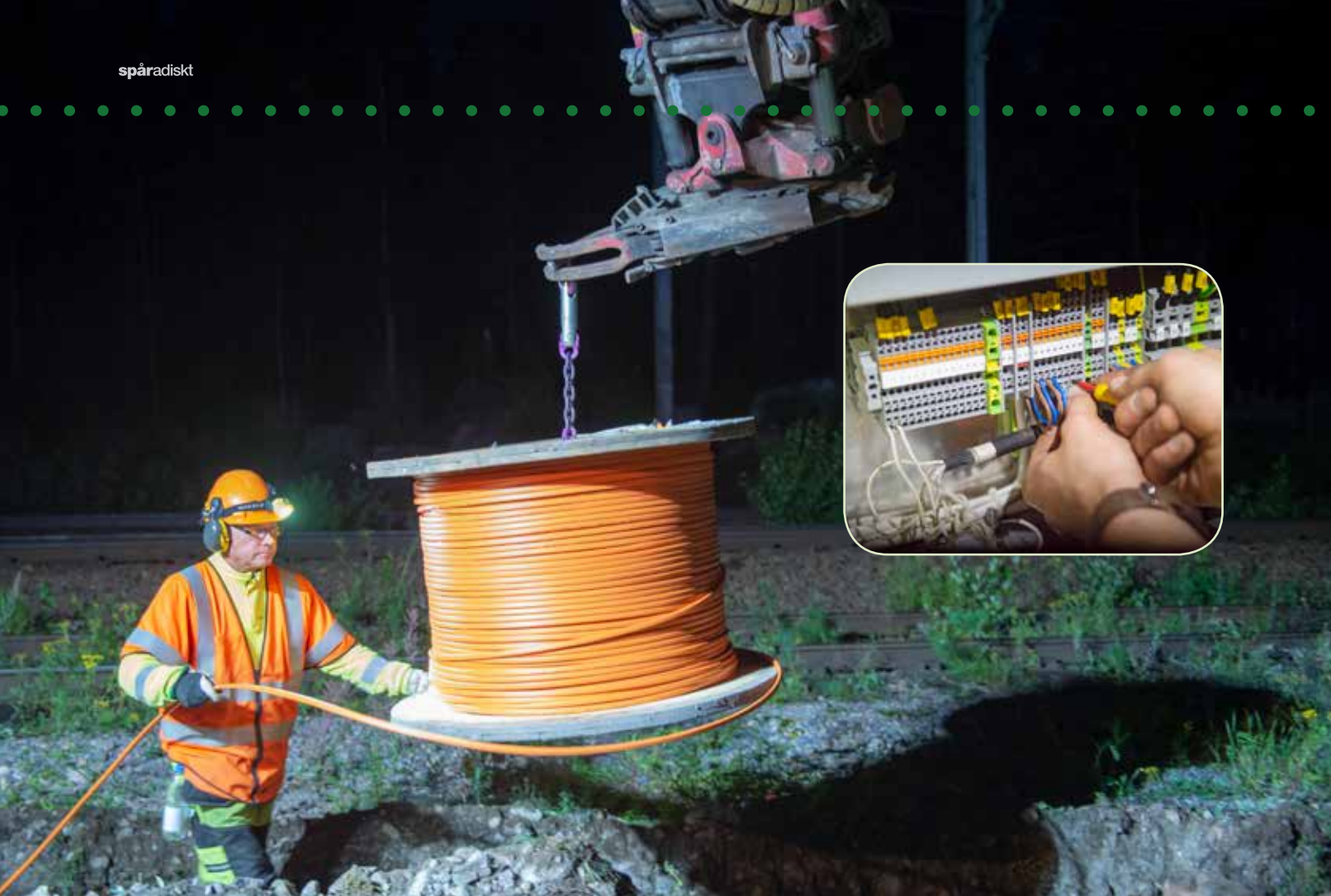
Fiberdukten matas ner i det nygrävda diket, från växelvärmeskåpet till teknikhuset.
