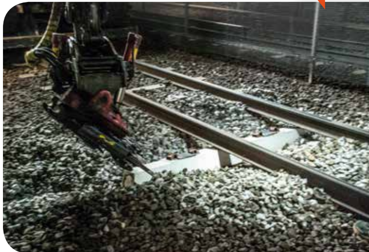
Traktorförare Joakim Hansson drar ut de skadade sliplarna.
