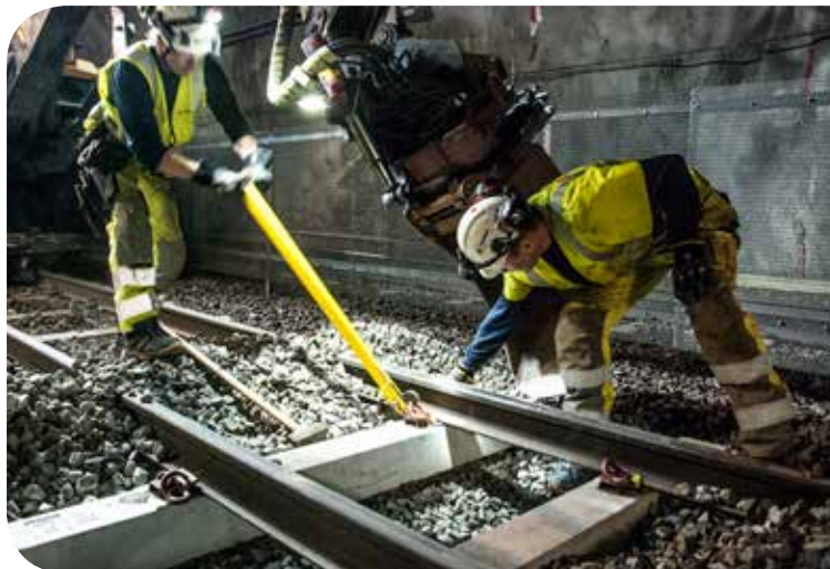
Fredrik och Robin slår loss pandrolerna som låser fast slipern vid rälen.
