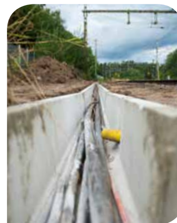
Kabelgrav vid Åby.
