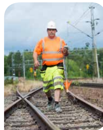
Lennart Andersson från JBA Entreprenad lägger kanalisat.
