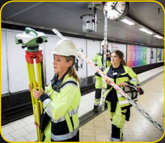
Som mättningsingenjör på Strukton arbetar Mimmi med att mäta spår och växlar på underhållskontraktet för SL.
