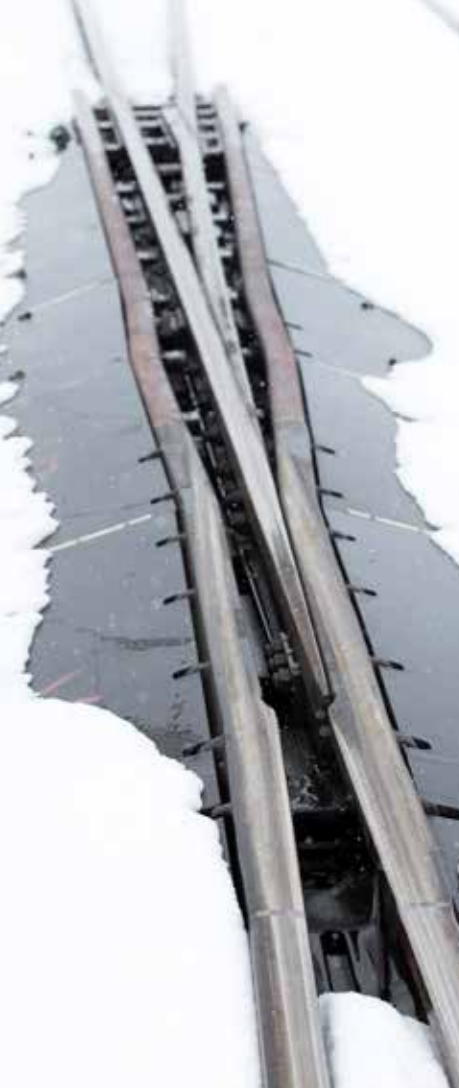
Den rörliga delen av spetsen är utbytbar.
