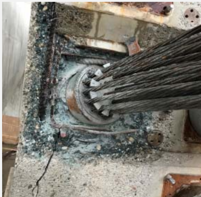
FOTO 3 – DETAIL VAN DE SPANKOP
