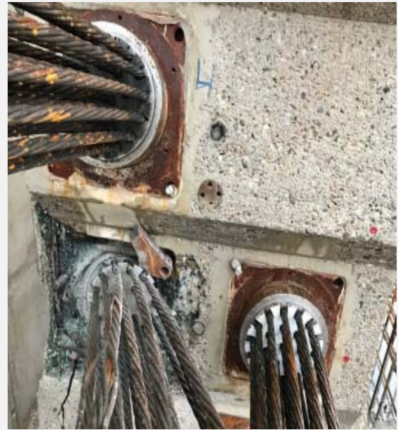
FOTO 2 – SPANKOP MET STUKJE ACHTERGEBLEVEN STAAL
